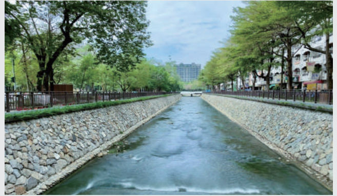
▲ 綠川經污水處理、水質淨化與環境綠美化後，展現「綠柳成蔭、川流生景」風華
