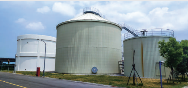
▲ 外埔綠能生態園區厭氧設備
