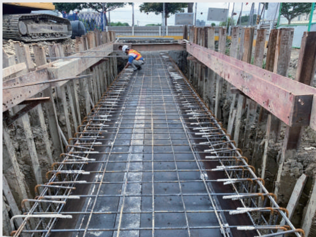
▲ 潭子區民生街之雨水下水道工程
