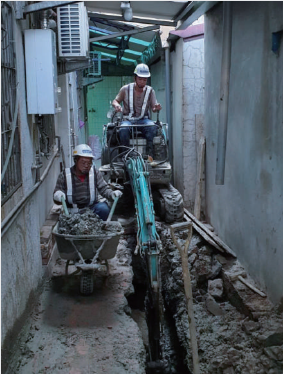
▲ 西區污水用戶接管工程施工情形
