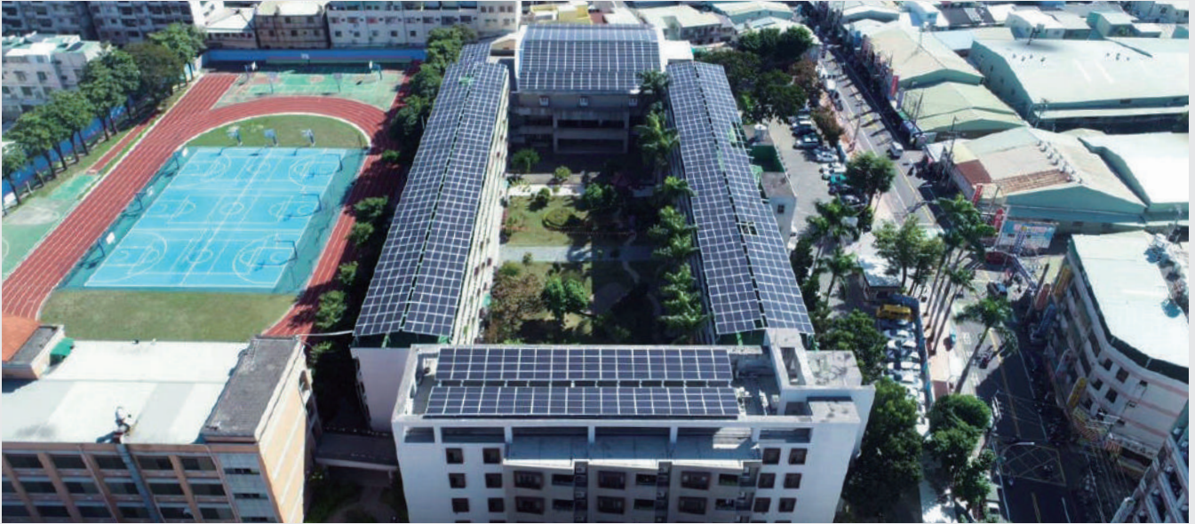
▲ 臺中市立中平國民中學屋頂鋪設光電
